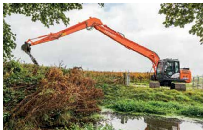
Machines de construction pour applications spéciales
